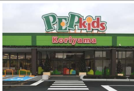
ペップキッズこおりやま 竣工：2011年12月 あそび場の広さ：1,650㎡ 場所：福島県郡山市
